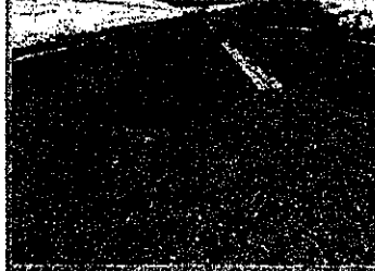
降雨・融雪に伴う舗装損傷(全面に渡る損傷)
