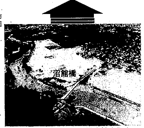
令和4年8月豪雨により洪水被害発生
