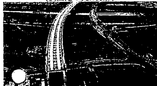
県内産業や地域の救急医療を支える幹線道路の整備
