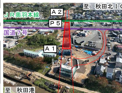
2号橋 (A 1側より)
