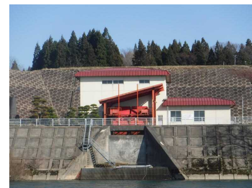
〔鷹巣三堰揚水機場（北秋田市）〕
