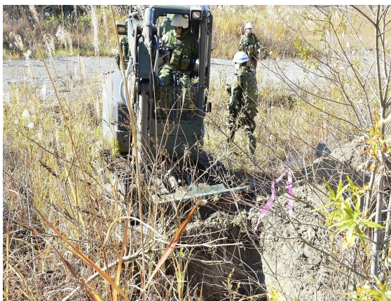
埋設のための堀開(北秋田市)
