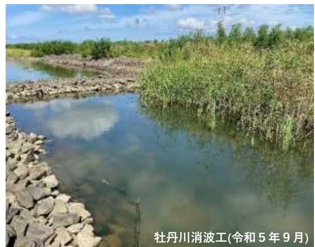
図 40 消波工内の植生の状況
