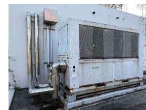
左上：空冷チラーユニット 左下：空冷マルチエアコン 右下：空冷マルチエアコン（室内）
