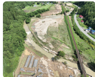
堤防決壊による農地等への被害
