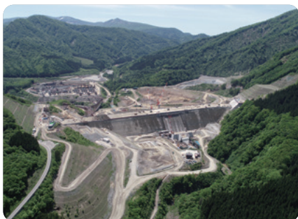
成瀬ダム工事現場
