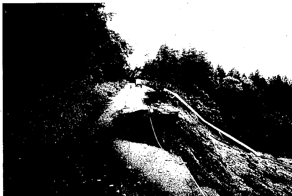
林道の路体崩壊（能代市久喜沢）
