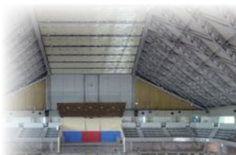
県立体育館の改修工事の様子
