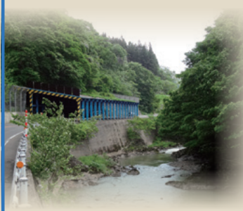
国道107号大築工区
