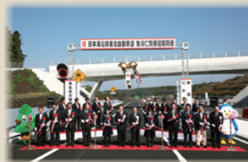
2015年10月18日に開通した 日本海沿岸東北自動車道 象潟仁賀保道路
