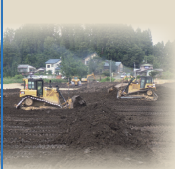
分離・分割方式により発注された米東部地区農地集積加速化基盤整備工事(横手市)
