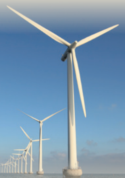
洋上風力発電施設(デンマーク)
