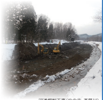
河道掘削工事(仙北市・斉藤川)
