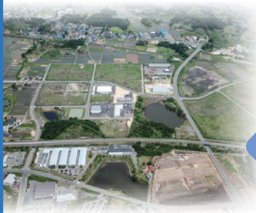
横手第二工業団地 (横手市)
