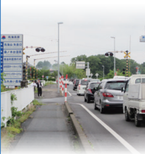
国道108号 黒沢踏切(由利本荘市)
