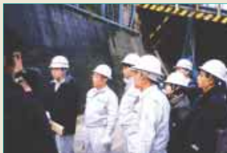
土砂崩落事故の現場で説明を受ける建設委員
