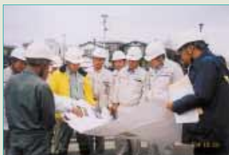
山本町森岳地区で三種川河川改修事業の現場説明を受ける建設委員
